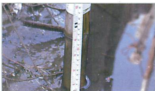
ヘドロの高さを測定：元の高さ（白テープ下端）より約20cm低下した。
